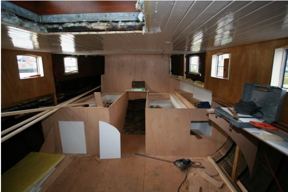
Die neuen grosszügigen Gästekojen werden aufgebaut
