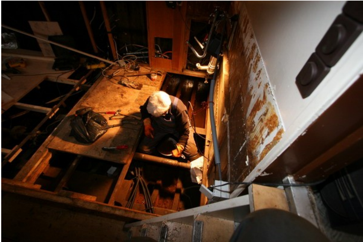
Entrosten der Bilge und Auftragen von Rostschutz
