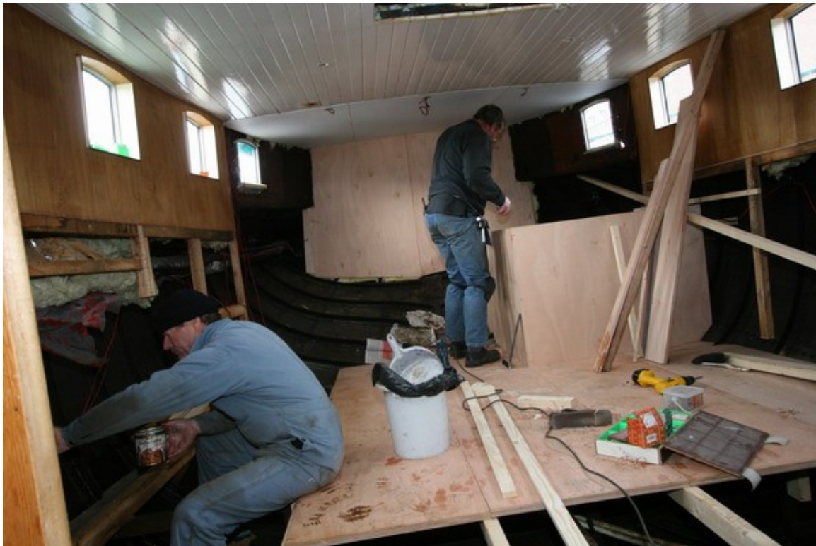
Isolation mit Steinwolle und Aufbau der neuen Achterkajüte
