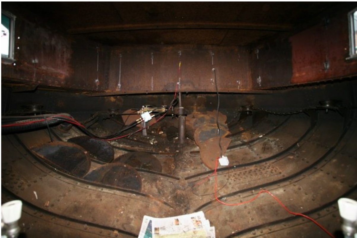
Abbruch der Achterkajüte bis auf den blanken Stahl
